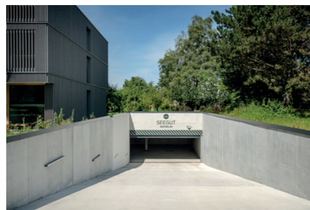
Zufahrt zur Tiefgarage mit Stellplätzen, teilweise mit Wallboxen
