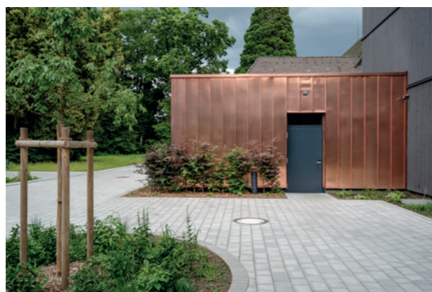
Kupferverkleideter Anbau, in dem die Küche untergebracht ist.
